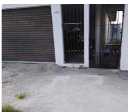
Resolução: Vazamento Saneado
