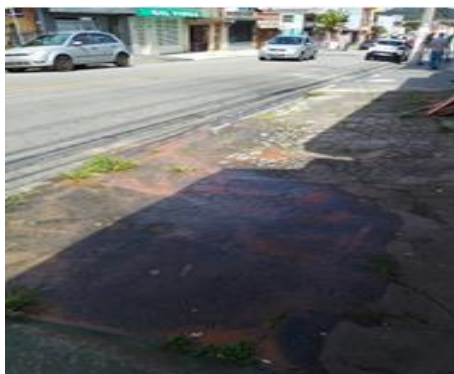
Chamado: Vazamento na Calçada
