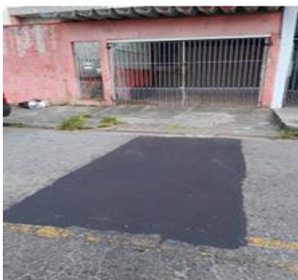
Resolução: Reposição Asfáltica
