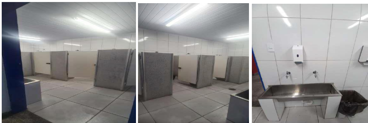
Desconformidades nos banheiros saneadas
