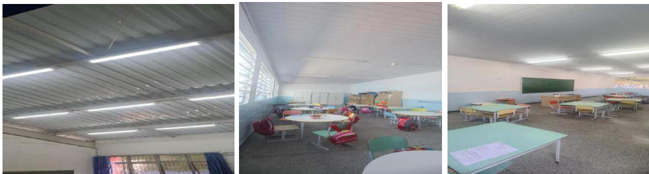
Problemas no telhado saneados
