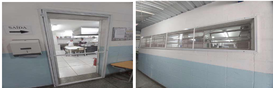
Telas milimetradas instaladas
